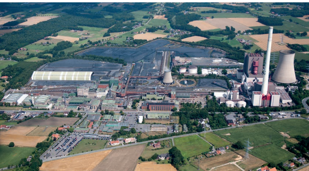
Luftbild Schachtanlage von Oeynhausen
