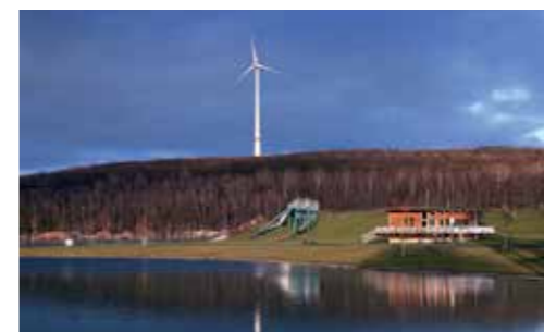
Windenergieanlage Halde Lohberg-Nord, Dinslaken
